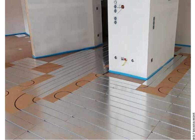
Bauherr Thomas Becker packte sogar selbst bei der Bodenverlegung mit an. Sein Fazit: „Natürlich erfordert das Verlegen der einzelnen Lagen inklusive Zuschnitts und teilweise Verkleben mehr Arbeitsstunden als zum Beispiel das Gießen eines Nass Estrichs. Zieht man allerdings dessen Trocknungszeit in Betracht, hat man zeitlich sogar gewonnen. Wir
