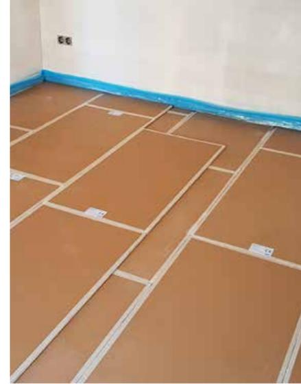
◀ Insgesamt vier Lagen Schalldämmplatten sorgen bei leichtem Aufbau für einen effizienten Schallschutz
